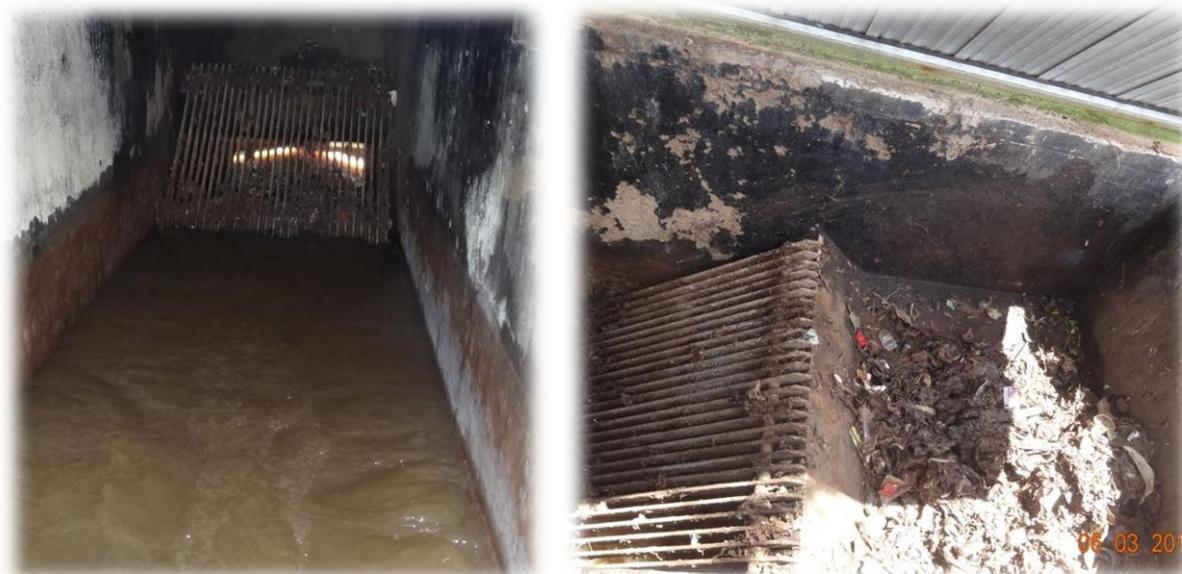
**Figura 23 - Detalhe da grade de barra de ferros de limpeza manual (esquerda) e da bandeja de drenagem (direita).**
