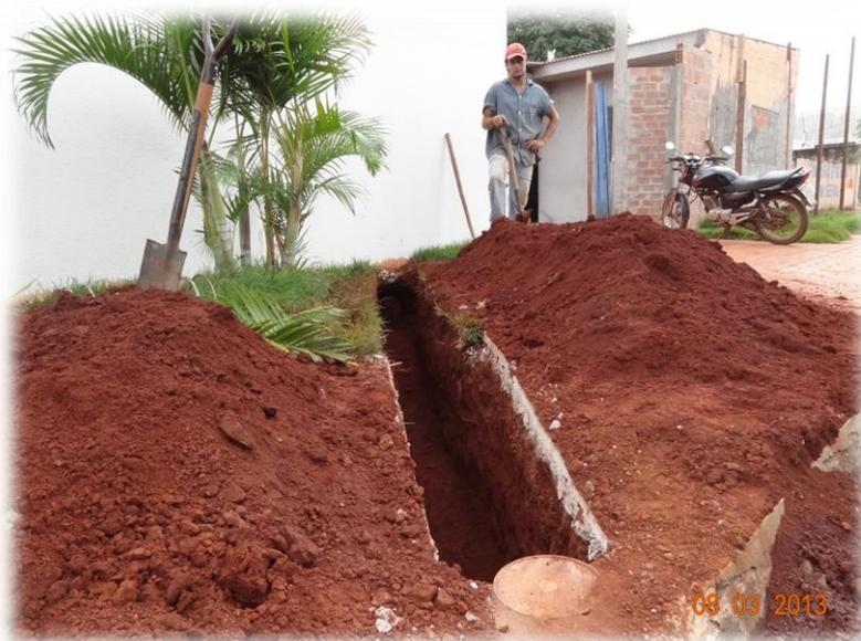
**Figura 3 - Execução de ligação predial à rede coletora de esgotos no município de São Gabriel do Oeste/MS.**
