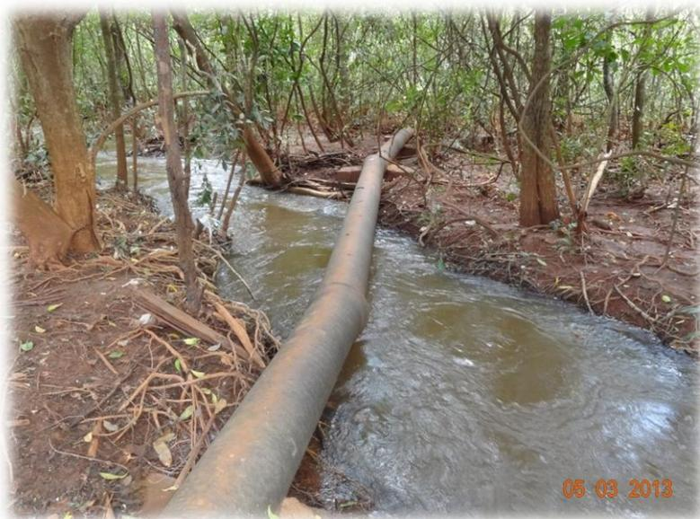
**Figura 6 - Tubulação de 300 mm que conduz o esgoto coletado da sub-bacia de contribuição "A" até a EEE-01, atravessando o Córrego Capão Redondo.**
