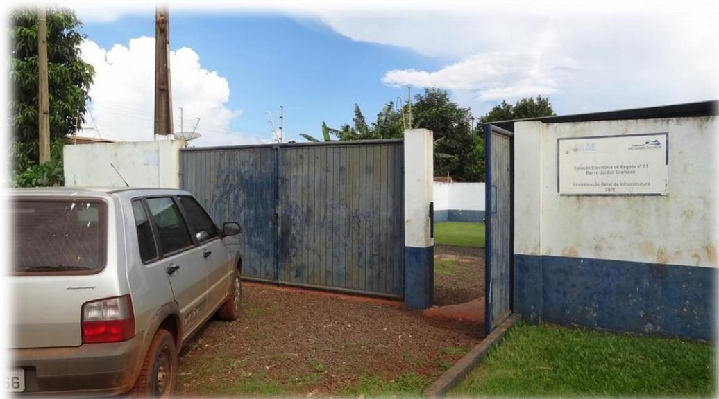
**Figura 4 – Aspecto construtivo externo da EEE-01 que possui muro em alvenaria, portão e dispositivo de cerca eletrificada evitando o acesso de pessoas não autorizadas.**
