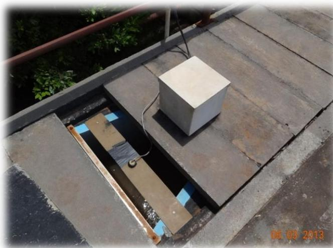
**Figura 25 - Sensor eletrônico de nível instalado a 2/3 da distância total do trecho convergente do medidor *parshall*.**
