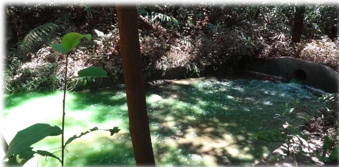
**Figura 37 - Dispositivo dissipador de vazão no ponto de lançamento de efluentes da ETE-São Gabriel.**
