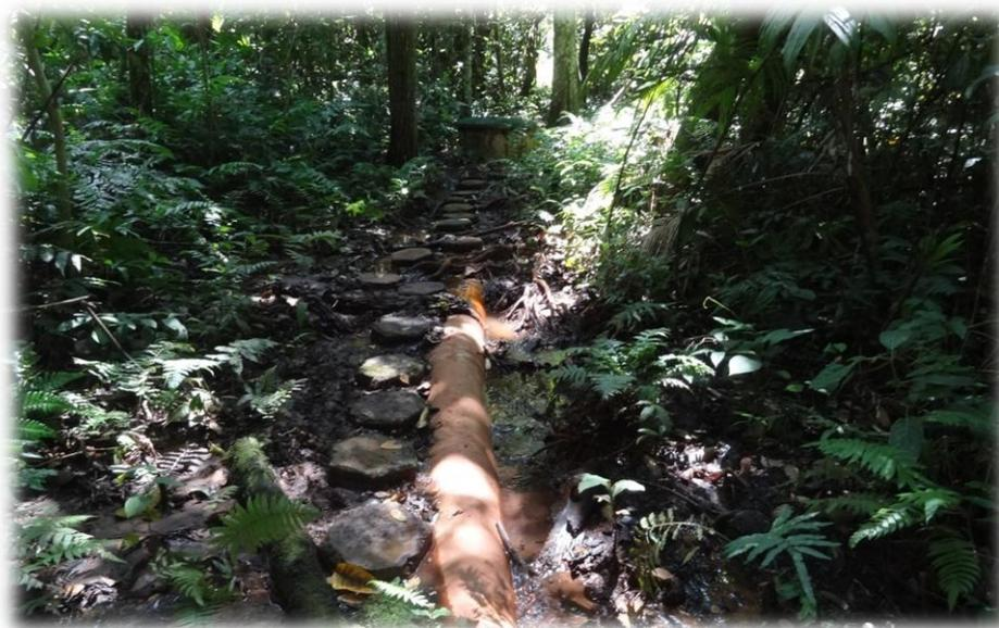
**Figura 36 - Emissário final que conduz o esgoto tratado até o corpo receptor (Rio Coxim).**
