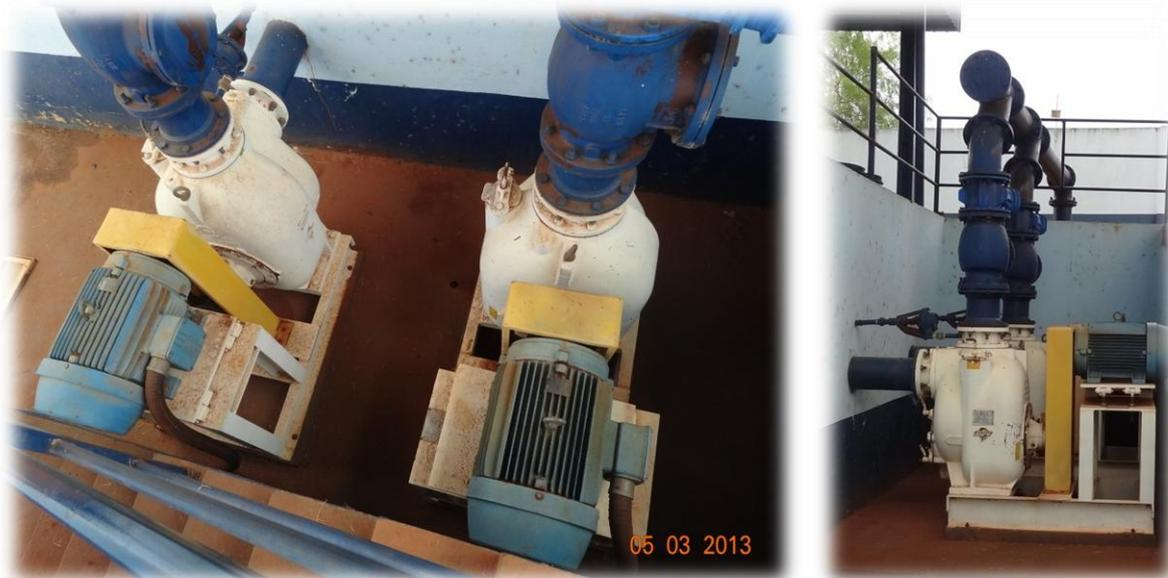
**Figura 10 - Conjuntos moto-bomba ESCO® (modelo LP-8) da Estação Elevatória de Esgotos nº 01 de São Gabriel do Oeste/MS.**
