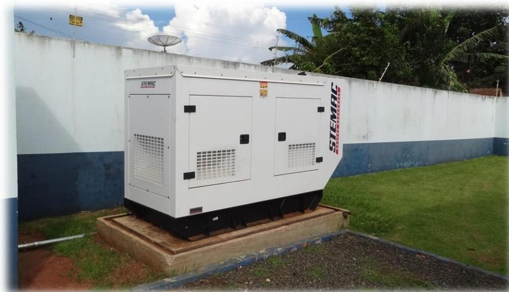
**Figura 11 - Detalhe do gerador instalado junto a EEE-01, evitando interrupções operacionais do sistema de bombeamento de esgotos.**
