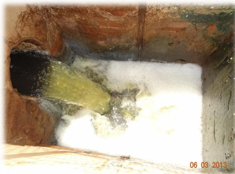
**Figura 33 - Caixa de passagem que interliga o dispositivo de saída da lagoa anaeróbia com o dispositivo de entrada da lagoa facultativa.**
