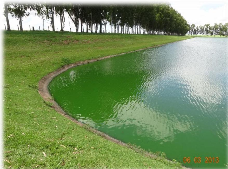
**Figura 30 - Detalhe dos cantos ligeiramente arredondados, nas esquinas das lagoas, e da proteção interna dos taludes.**
