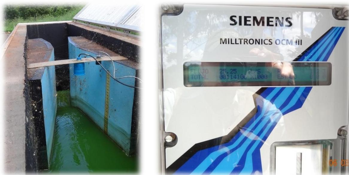
**Figura 35 - Medidor parshall na saída do sistema de lagoas de estabilização (à esquerda) e detalhe do monitor que apresenta os resultados convertidos em tempo real do sensor eletrônico de medição de nível (à direita).**
