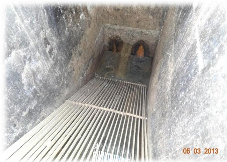
**Figura 16 – Chegada do esgoto bruto à Estação Elevatória de Esgotos nº 02 passando por uma unidade de gradeamento para retenção de sólidos grosseiros.**
