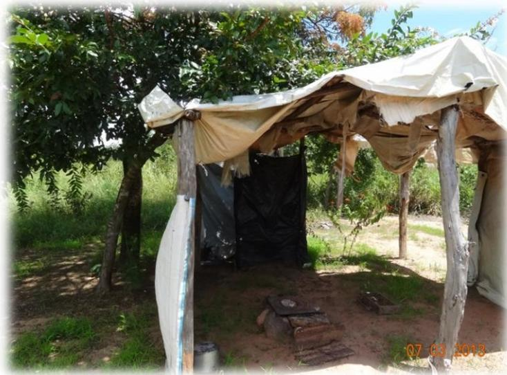
**Figura 46 – Casinha (ao fundo) composta por fossa seca escavada no solo, destinada a receber somente as excretas, no Assentamento Patativa do Assaré.**
