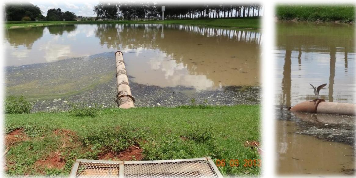
**Figura 32 - Dispositivo de saída de uma das lagoas anaeróbias (esquerda) e destaque da curva de 90° na extremidade da tubulação.**
