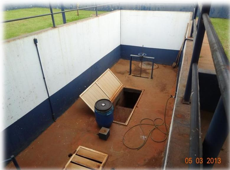
**Figura 7 - Comporta manual e unidade de tratamento preliminar compacta da Estação Elevatória de Esgotos nº 01.**
