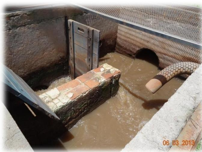
**Figura 31 - Caixa de passagem com dispositivo divisor de vazão que dá acesso às lagoas anaeróbias.**
