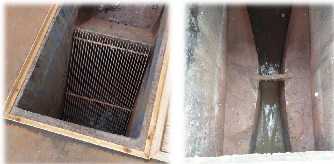
**Figura 8 – Detalhe da grade de barras de ferro (gradeamento) e do medidor Parshall da unidade de tratamento preliminar compacta na EEE-01.**
