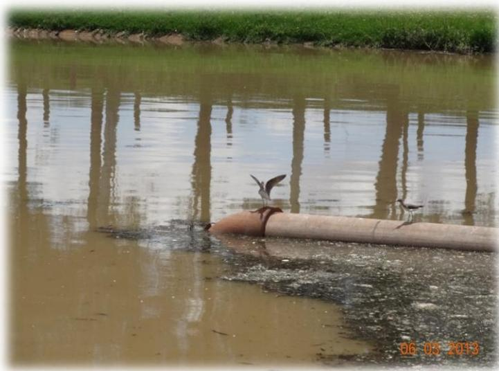
**Figura 28 - Presença de espuma característica na superfície líquida da lagoa anaeróbia da ETE-São Gabriel.**
