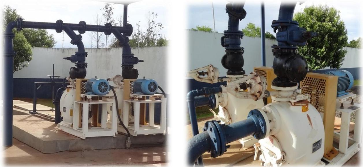
**Figura 18 - Conjuntos moto-bomba ESCO® (modelo LP-4) da Estação Elevatória de Esgotos nº 02 de São Gabriel do Oeste/MS.**
