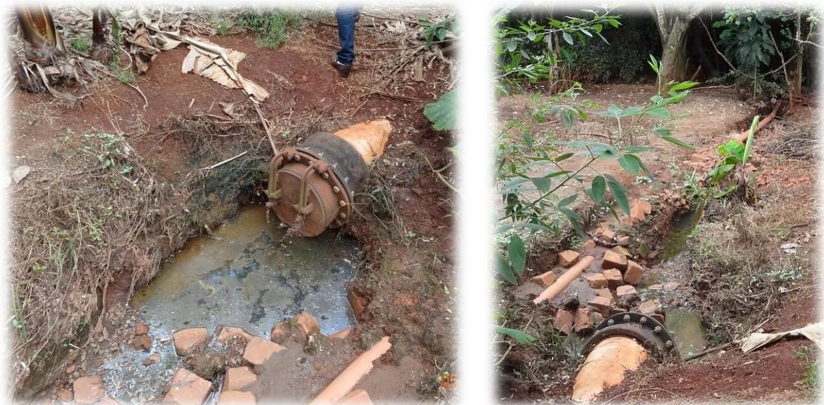
**Figura 13 – Detalhe do extravasador de esgotos do dispositivo de segurança da EEE-01.**
