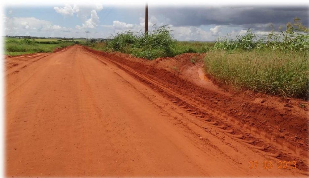
Figura 28 – Boa condição estrada em leito natural que atravessa o Assentamento Campanário.
