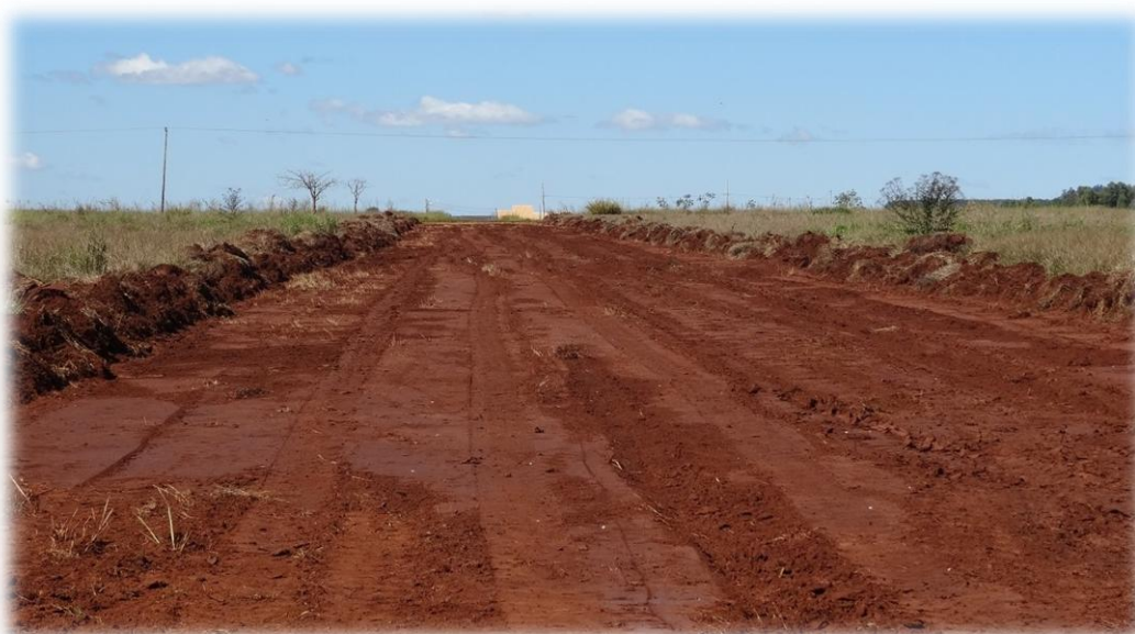
Figura 27 - Continuidade do traçado da rua em uma região de loteamento no Bairro Primo Maffissoni.
