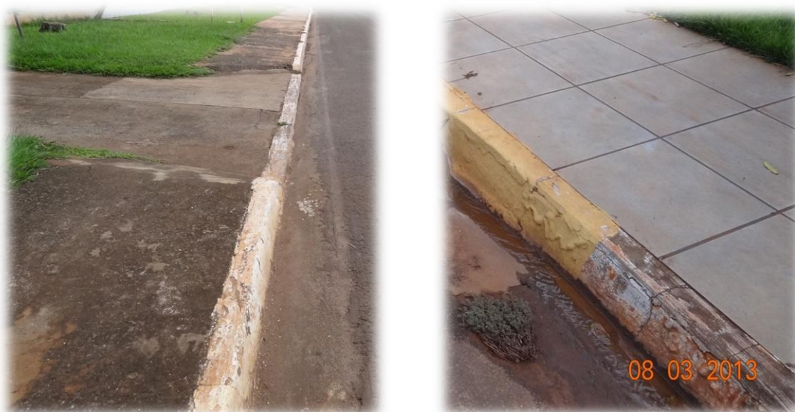
Figura 4 – Boas condições das sarjetas e meio fios de malha asfáltica do município de São Gabriel do Oeste/MS
