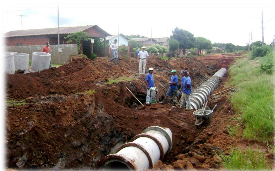
Figura 13 - Implantação de tubos de concreto (galeria de águas pluviais) no município de São Gabriel do Oeste/MS.
