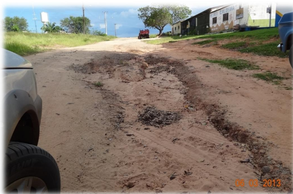
Figura 29 – Erosão pontual causada por águas de enxurrada no Distrito Areado.
