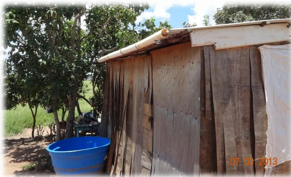
**Figura 65 - Detalhe da calha para captação de água das chuvas na cobertura da residência e da cisterna para a reservação.**
