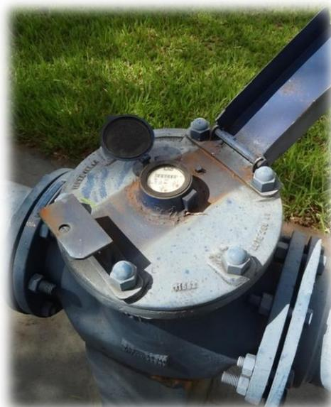
**Figura 23 – Poço tubular profundo – PT-02 e em destaque seu respectivo macromedidor.**
