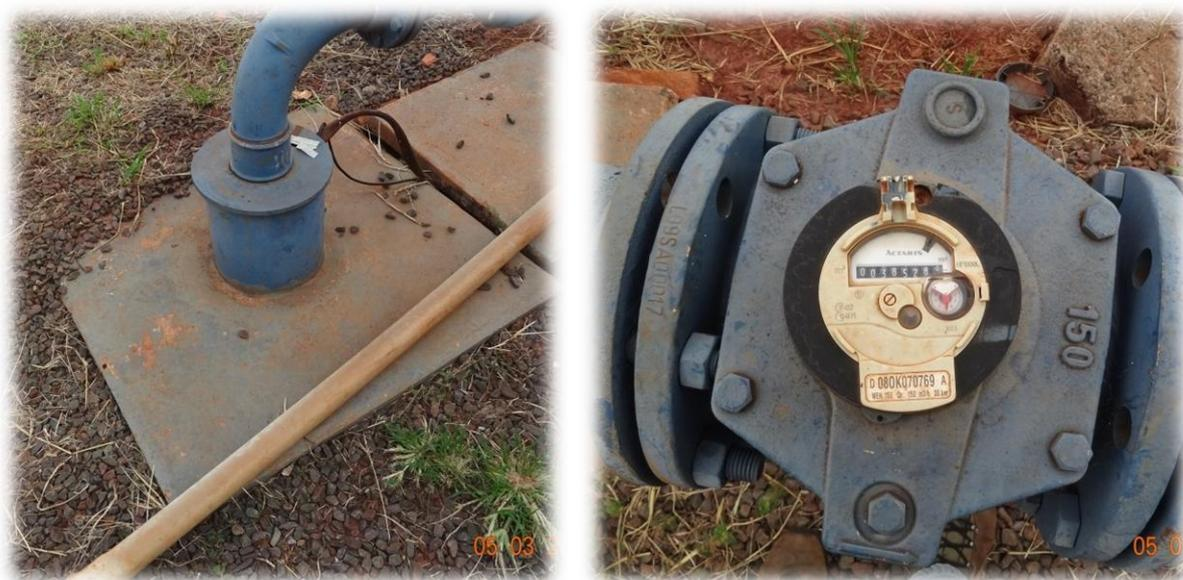
**Figura 40 – Poço tubular profundo – PT-08 e em detalhe seu respectivo macromedidor.**
