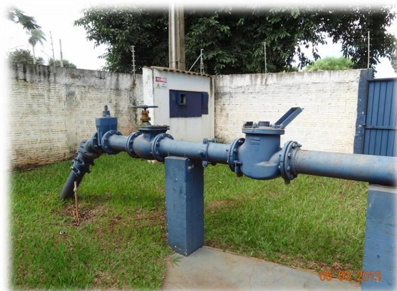
**Figura 12 - Detalhe do macromedidor no cavalete de saída do PT-03 localizado na UCA-03.**
