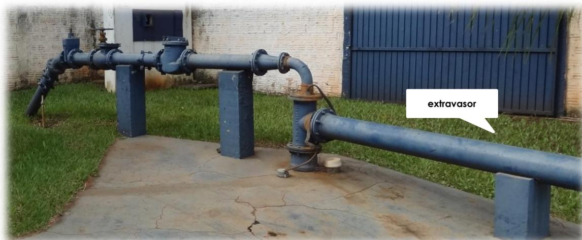
**Figura 4 – Detalhe do extravasor de água "jorrada" e do cavalete de saída do PT-03.**
