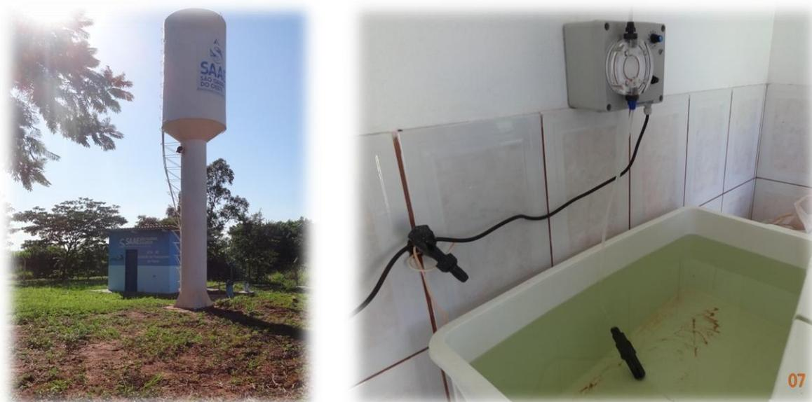
**Figura 60 - Reservatório elevado do tipo "taça" que atende o núcleo do Assentamento Campanário (à esquerda) e detalhe do reservatório de cloro e bomba dosadora que realiza o tratamento da água abastecida (à direita)**
