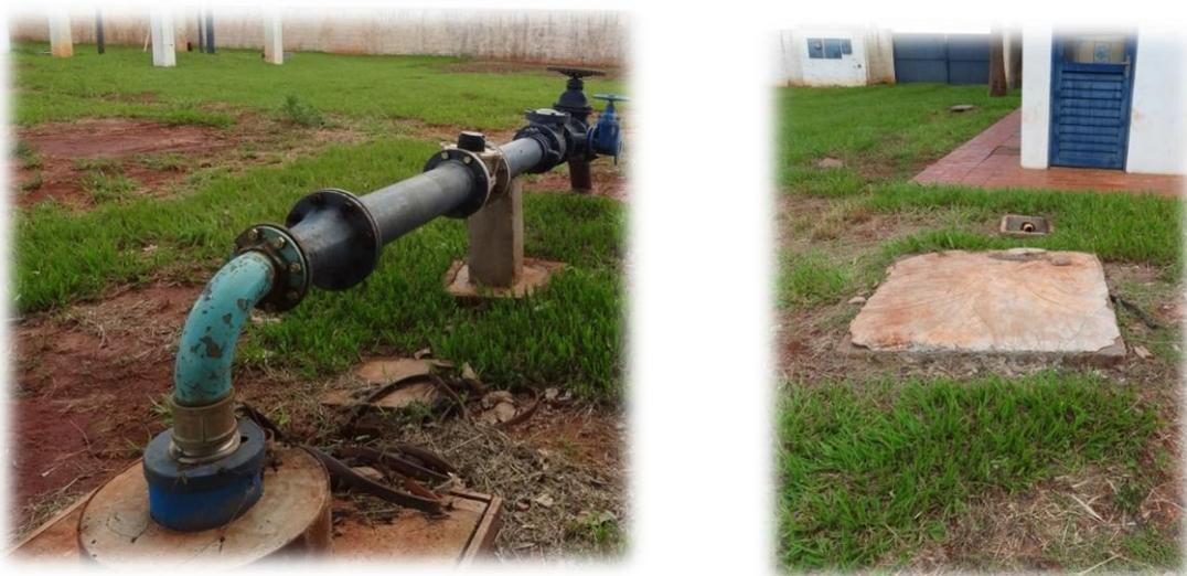
**Figura 33 – Poço tubular profundo – PT-04 (à esquerda) e poço tubular profundo desativado (à direita) ambos localizados junto à UTA-04.**
