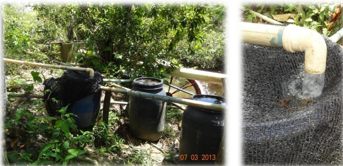
**Figura 62 - Filtração e sedimentação da areia da água proveniente do Rio Novo, que abastece alguns moradores dos assentamentos Itaqui e Patativa do Assaré.**
