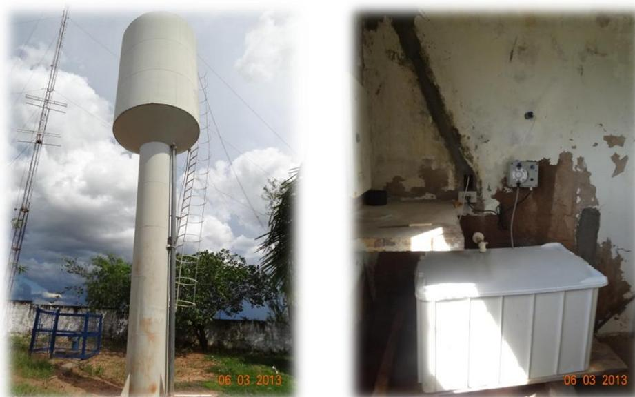
**Figura 54 - Reservatório elevado do tipo "taça" que atende o Distrito Areado (à esquerda) e detalhe do reservatório de cloro e bomba dosadora que realiza o tratamento da água abastecida (à direita)**
