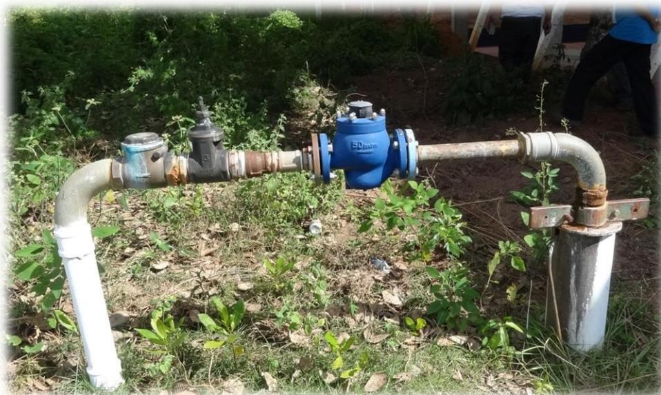
**Figura 52 - Detalhe do PT-05 e seu respectivo cavalete de saída, localizado no Distrito Areado.**
