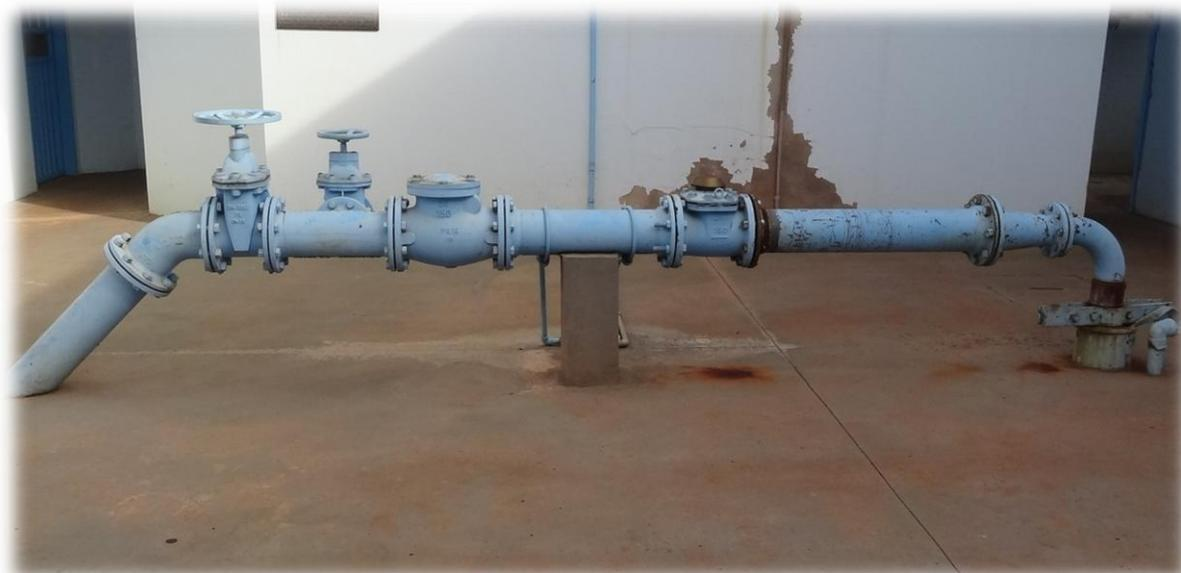
**Figura 18 – Detalhe do PT-01 e seu respectivo cavalete de saída localizado na Unidade de Tratamento de Água – UTA-01.**
