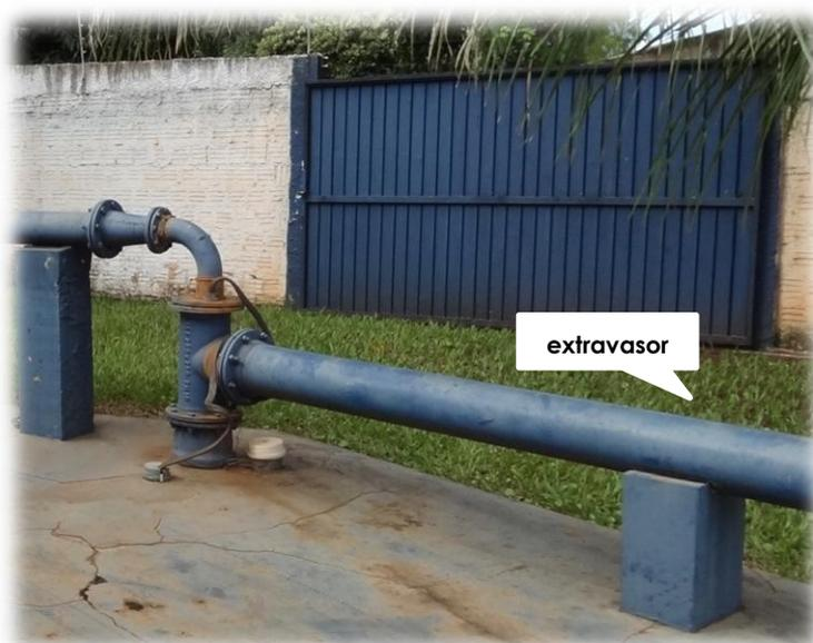
**Figura 9 – Detalhe do PT-03, da área pavimentada e do extravasor da água "jorrada" da Unidade de Captação de Água - UCA-03.**
