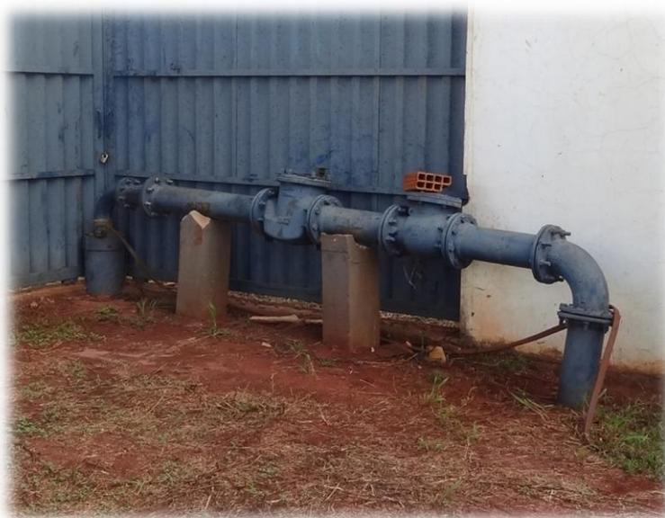
**Figura 14 – Detalhe do cavalete de saída do PT-07 da Unidade de Captação de Água - UCA-07.**
