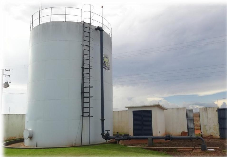
**Figura 41 - Detalhe da adutora e do reservatório apoiado - RAP-02 da Unidade de Tratamento de Água - UTA-08.**
